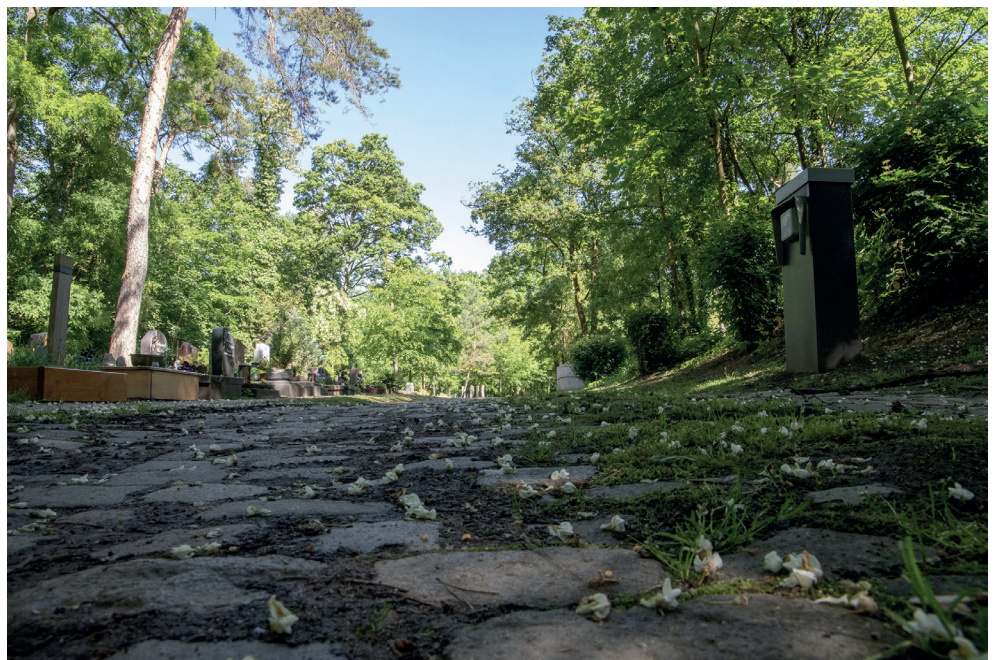
Einfahrtsbereich zum Gonsenheimer Friedhof: Hier startet der erste Bauabschnitt der Gewegesanieierung
